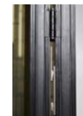
Têtes de vis masquées par des caches noirs participants à l'étanchéité
